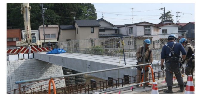
橋桁架設工事が行われためもと橋
